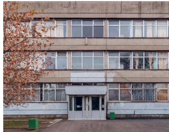
Конструкција је армиранобетонска, са масивним носећим зидовима. Бочни носећи зидови су изоловани са унутрашње стране термоизолацијом дебљине 10cm, док су парапетне испуне од армираног бетона дебљине 20cm без термичке изолације. У склопу равних кровова и подова на тлу постоји термоизолација али ниједан елемент термичког омотача не одговара актуелним стандардима.
