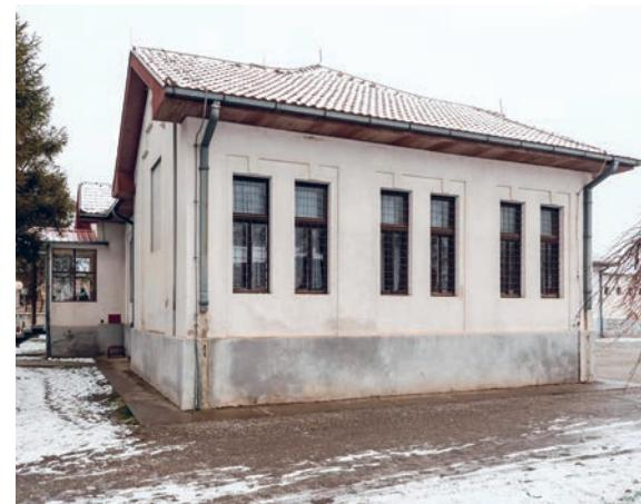
Школске зграде овог типа рађене су једноставним традиционалним техникама грађења. Конструктивни склоп је масиван, са дрвеном међуспратном конструкцијом („каратаван“) и косим вишеводним кровом. Фасадни зидови су обострано малтерисани, са елементима једноставне декоративне пластике, без термичке изолације. Прозори су дрвени, двоструки, застакљени једноструким стаклом. Подови су у форми бродског пода и на подлози од набијене земље.
