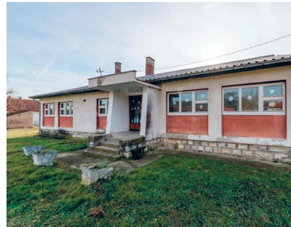
Школске зграде овог типа рађене су у масивном конструктивном склопу, са носећим зидовима од пуне опеке. Према тавану је дрвена међуспратна конструкција а кровна конструкција је једноставна традиционална. Фасадни зидови су обострано малтерисани, без термичке изолације; прозори су дрвени, двоструки, са раздвојеним крилима а заштита од сунца је у виду платнених ролетни. Подови су са дрвеном облогом (углавном паркет) без термичке изолације.
