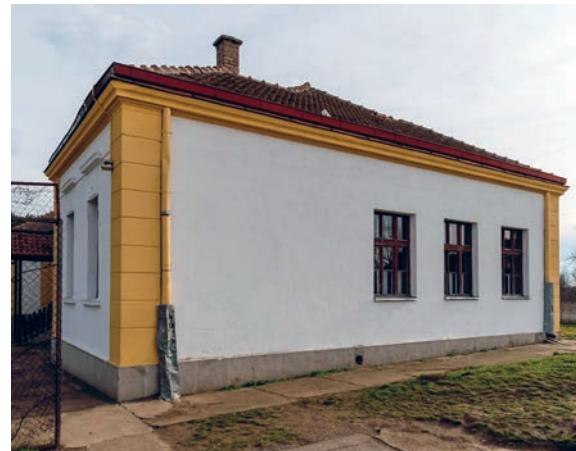
Школске зграде овог типа рађене су једноставним традиционалним техникама грађења. Конструктивни склоп је масиван, са дрвеном међуспратном конструкцијом („каратаџан“) и косим двоводним кровом. Фасадни зидови су обострано малтерисани, са елементима једноставне декоративне пластике, без термичке изолације. Прозори су дрвени, двоструки, са раздвојеним крилима, застакљени једноструким стаклом. Подови су са дрвеном облогом, без термичке изолације.
