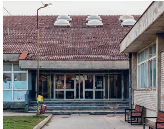
Школске зграде овог типа рађене су у армиранобетонском скелетном систему. Елементи скелетне конструкције, као и фасадни зидови од фуговане силикатне опеке са спољашње стране су немалтерисани, без термичке изолације. Конструкција косог крова је пуне армиранобетонска плоча, са 5cm термоизолације и бетонским црепом на дрвеној потконструкцији. Прозори су дрвени, двоструки, са спојеним крилима („крило на крило“) застакљени једноструким стаклом.
