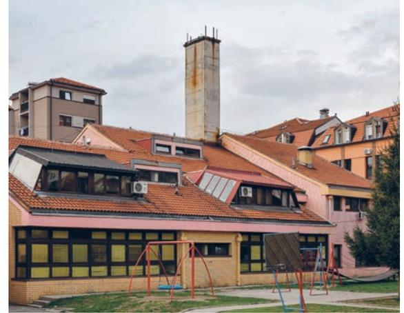
Објекат је рађен су у масивном армиранобетонском систему, са бетонским таваницама и дрвеном кровном конструкцијом. Фасадни зидови су махом сендвич конструкције са армираним бетоном, термоизолацијом и фасадном опеком. У склопу косог крова термоизолација је у дебљини рогова (12cm). Прозори су дрвени, једноструки, застакљени двоструким термоизолационим стаклом. Подови су рађени у складу са наменом просторије, на бетонској плочи без термоизолације.
