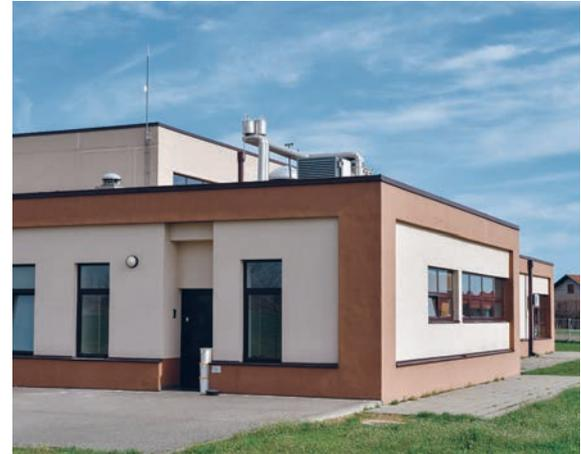
Објекат је рађен су у скелетном армиранобетонском систему, са таваницама од пуних бетонских плоча. Фасадни зидови су сендвич конструкције (гитер блок, термоизолација и пуна опека), обострано малтерисани. Непроходан раван кров има XPS термоизолацију дебљине 12cm. Фасадна столарија је комбинација пластифицираног алуминијума и дрвета, застакљена двоструким термоизолационим стаклом. Подови су рађени на бетонској плочи са термоизолационим слојем.
