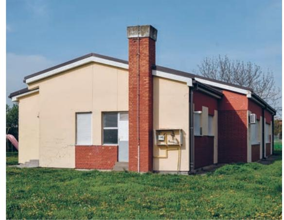
Конструктивни склоп је масиван са зидовима од гитер блока, армиранобетонском таваницом и косим двоводним кровом традиционалне конструкције. Фасадни зидови су обострано малтерисани, без термичке изолације, али и без декоративне пластике што омогућава једноставне мере енергетске рехабилитације фасаде. Прозори су дрвени, двоструки са спојеним крилима, застакљени једноструким стаклом. Подови су рађени на бетонској плочи без термичке изолације.
