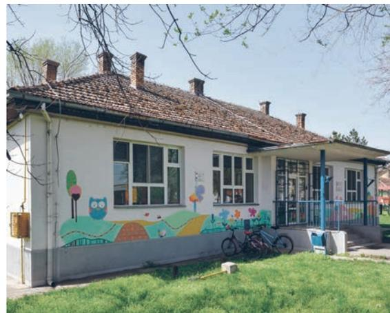
Конструктивни склоп је масиван, са армиранобетонском таваницом изнад подрума, дрвеном међуспратном конструкцијом („каратаван“) и косим двоводним кровом. Фасадни зидови су обострано малтерисани, без термичке изолације, али и без декоративне пластике што омогућава једноставне мере енергетске рехабилитације фасаде. Прозори су дрвени, застакљени једноструким стаклом. Подови су са дрвеном облогом без термичке изолације.
