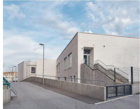
Конструкција објекта је армиранобетонска са зидним платнима и пуним таваничним плочама. Фасадни зидови су "сендвич" конструкције (гитер блок 20cm, термоизолација 20cm и опека 12cm), обострано малтерисани. Сви елементи термичког омотача урађени су у складу са актуелним прописима из области термичке заштите. Фасадна столарија је алуминијумска са побољшаним термопрекидом и нискоемисионим двоструким термоизолационим стаклом.
